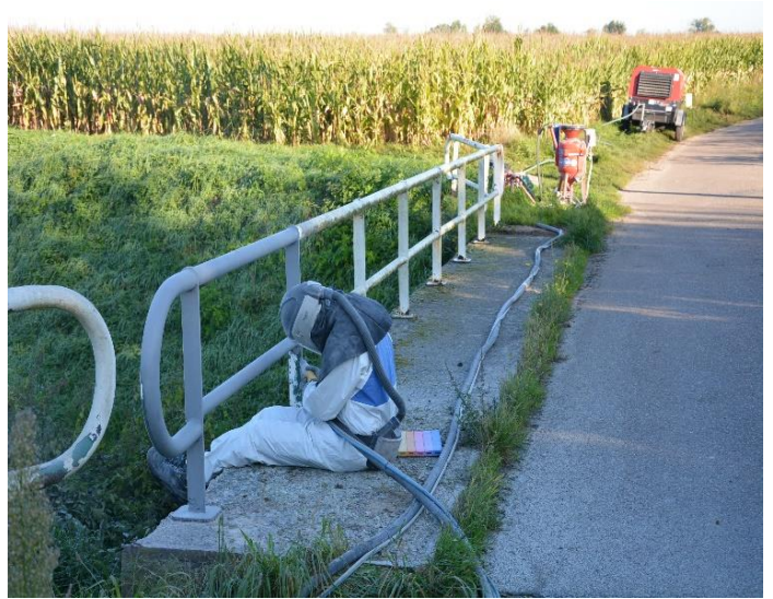
Le sablage des garde-corps dans la Itterstraat.
