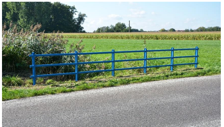
Brug in de Sevensstraat behandeld met Zingaceram
