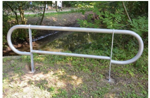
Behandelen van de brug in de Doorslagstraat met Zingalufer
