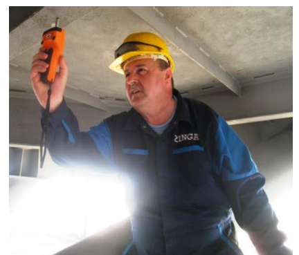
Droite: Inspection de la surface
