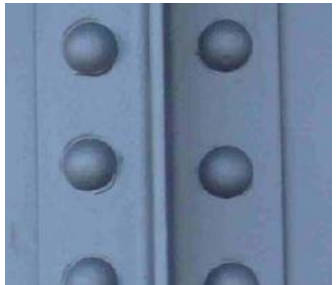
Typisch beeld van staalwerk na ZINGA applicatie. Alle klinknagels, hoeken en bouten kregen een grondlaag.
