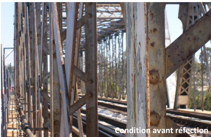
Condition avant réfection
