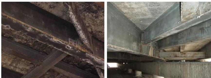
Ces photos indiquent clairement le haut degré de corrosion avant réparation avec le système **ZINGA**
