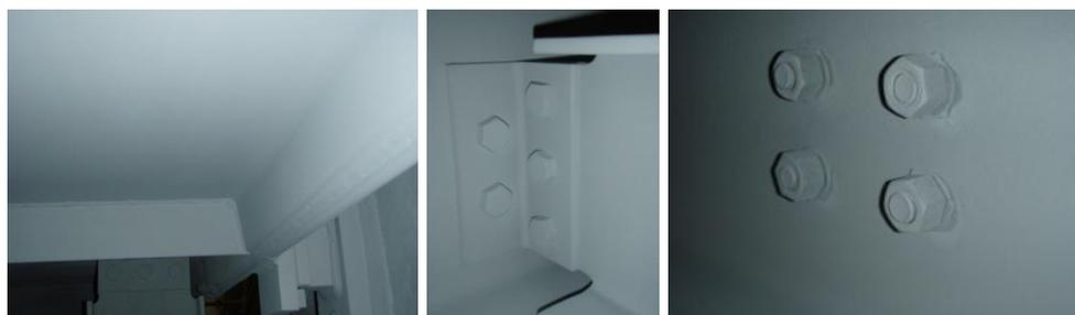
Suivi d'une couche de **Monoprimer** (80µm EFS) et d'**Alufer WR** (80µm EFS)
