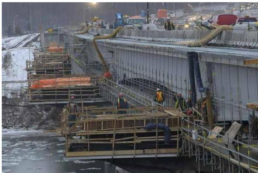
Le **ZINGA** a été utilisé sur les poutres qui forment le support de l'extension latérale du pont et de la balustrade.
