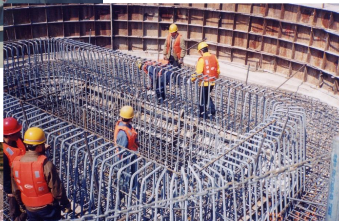
Beton ijzers behandeld met ZINGA
