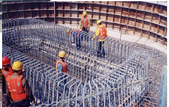
Fers à béton protégés au ZINGA
