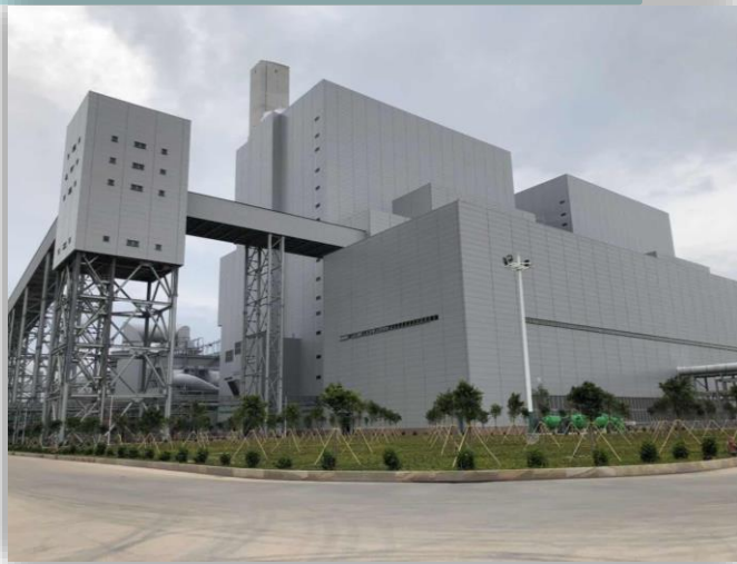
Steenkoolbunkers, 12 enorme zware steenkool dispensers (elk 63 Ton), allemaal gefabriceerd en bekleed met ZINGA op locatie in Lufeng.
