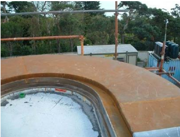
Vue d'un coin du toit montrant le canal d'écoulement.
