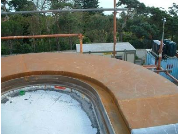
Beeld van het gootwerk van het afdak/balkon
