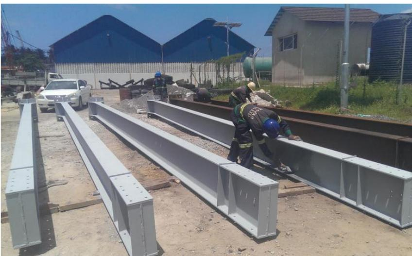
En 2015, les poutres des structures métalliques du Chantier Naval KPA ont été traités avec **ZINGA** afin de les protéger contre la corrosion dans ce milieu marin agressif.
