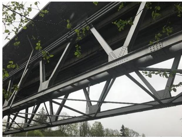
Ces photos ont été prises en Mai 2016, **soit après 15 ans d'exposition**. Le système est encore toujours intact sans aucune trace de rouille. Même aux endroits critiques, autour des boulons et rivets, l'on a constaté aucun défaut. Le système est conçu pour protéger sa structure acier pendant encore de nombreuses années.
