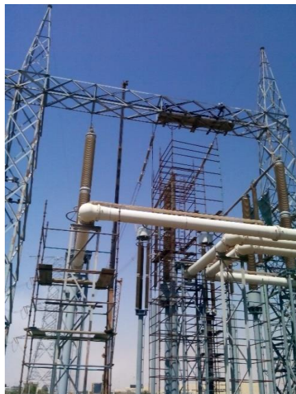
Pylônes pendant le traitement
