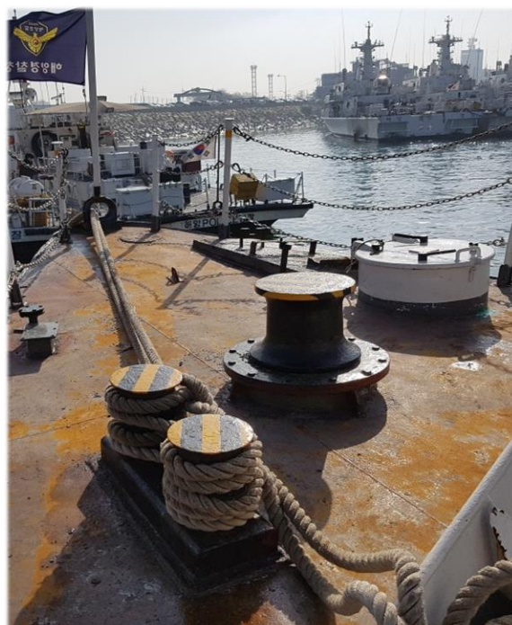
Après suppression du revêtement existant
