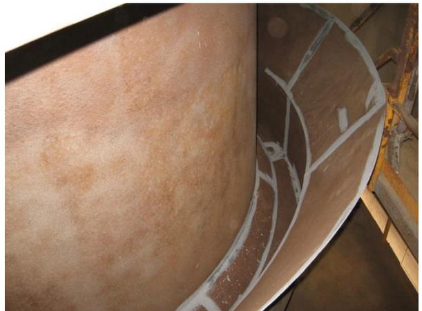
Couche d'apprêt sur les cordons de soudures, boulons et bords aigus
