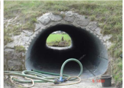
Prêt pour sablage et peinture du caniveau en acier.
