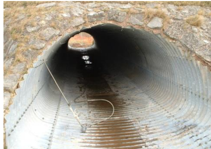
Balayage du sol avant sablage
