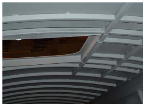
Avant installation des panneaux contre le plafond
