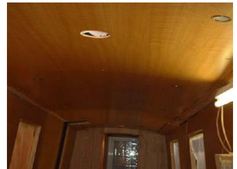
Après installation des panneaux contre le plafond
