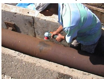
Meulage par brosse rotative pour déroueillir la canalisation
