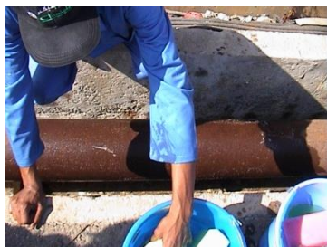
Nettoyage / Dégraissage au détergent et rinçage à l'eau claire
