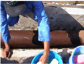
Reinigen/ Ontvetten met detergent en spoelen met zuiver water
