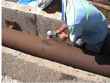
Slijpen met mechanische borstel om de buizen te ontroesten
