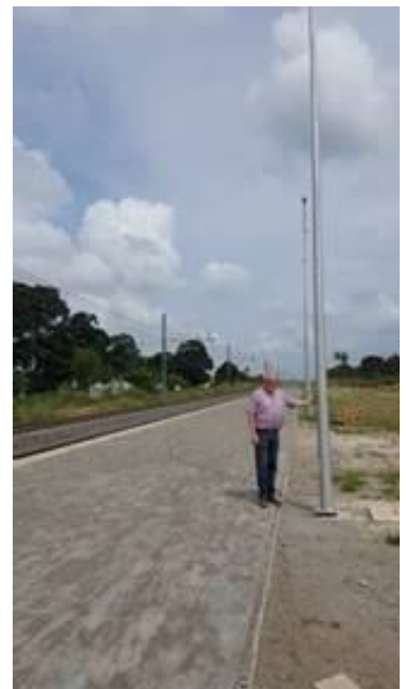
Condition des mâts avant application du système ZINGA
