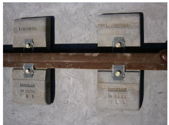
La société des chemins de fer **DORBRAS** était à la recherche d'une solution à l'oxydation des plaquettes métalliques utilisées pour la fixation des rails aux traverses. En avril 1999 environ 45.000 plaquettes de fixation Zinganisées ont été installées. Une couche de 80 µm de **ZINGA** a été appliquée au pistolet. Ces plaquettes sont en contact continu avec le bloc en béton au bout de chaque traverse et elles vibrent lors du passage d'un train sur ces rails.
