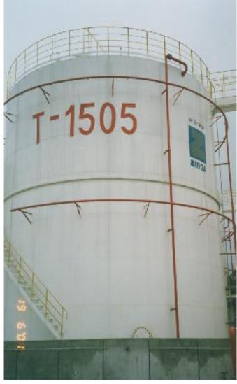
Système: ZINGA 1 x 60 μm EFS Finition 2 x 40 μm EFS
